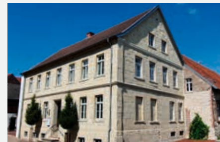
HAUPTHAUS GUT FEISMANN, BAUJAHR 1865
