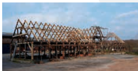
UMBAUARBEITEN AUF DEM GRÄFTENHOF
